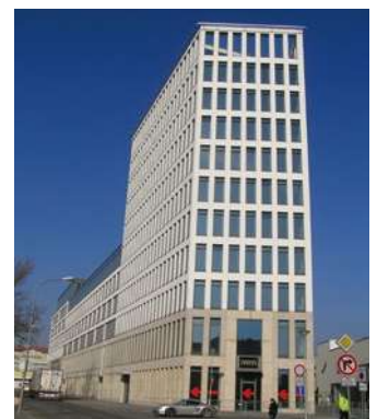
Bâtiment administratif Trinity, Brno, République tchèque
