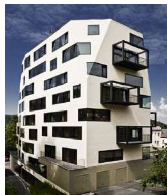
Triplex – immeuble résidentiel, Karlovy Vary, République tchèque
